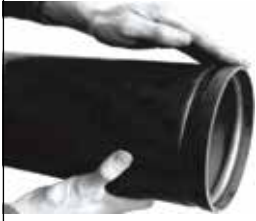
1. Boru hazırlığı Pipe preparation
