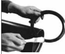
2. Contayı yağlayın Lubricate gasket
