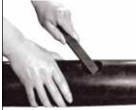
2. Çapakları temizleyin Remove burrs
