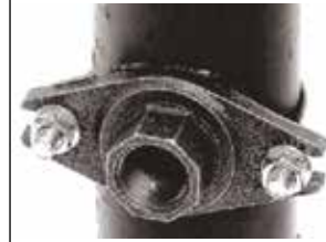
6. Montaj tamamlandı Assembly completed
