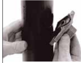
3. Conta montajı Gasket installation
