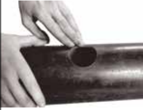
1. Boru hazırlığı Pipe preparation
